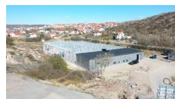
Swedish Algae Factory's anläggning
